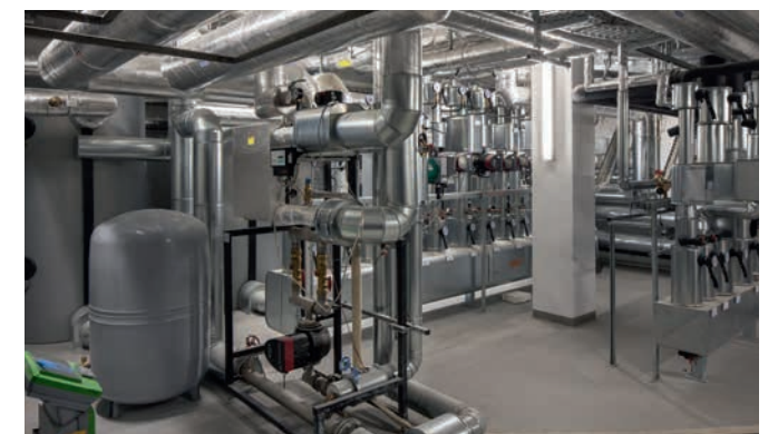
Heizungszentrale-Verteiler
