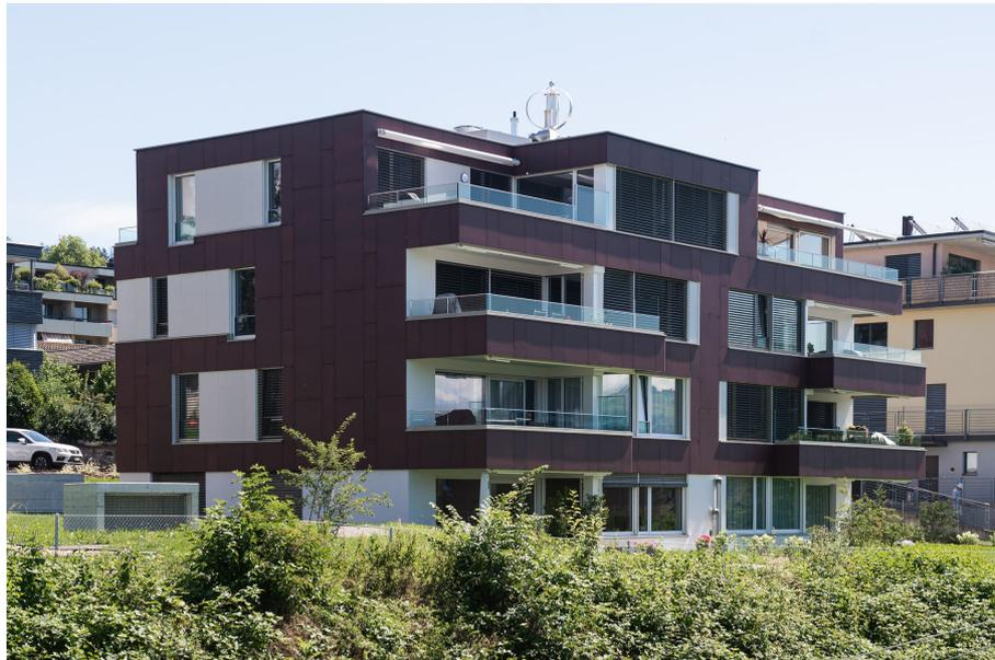
Die neuen Mehrfamilienhäuser in Männedorf sind bewohnbare Kraftwerke und fast vollständig in Solarmodule eingehüllt.
