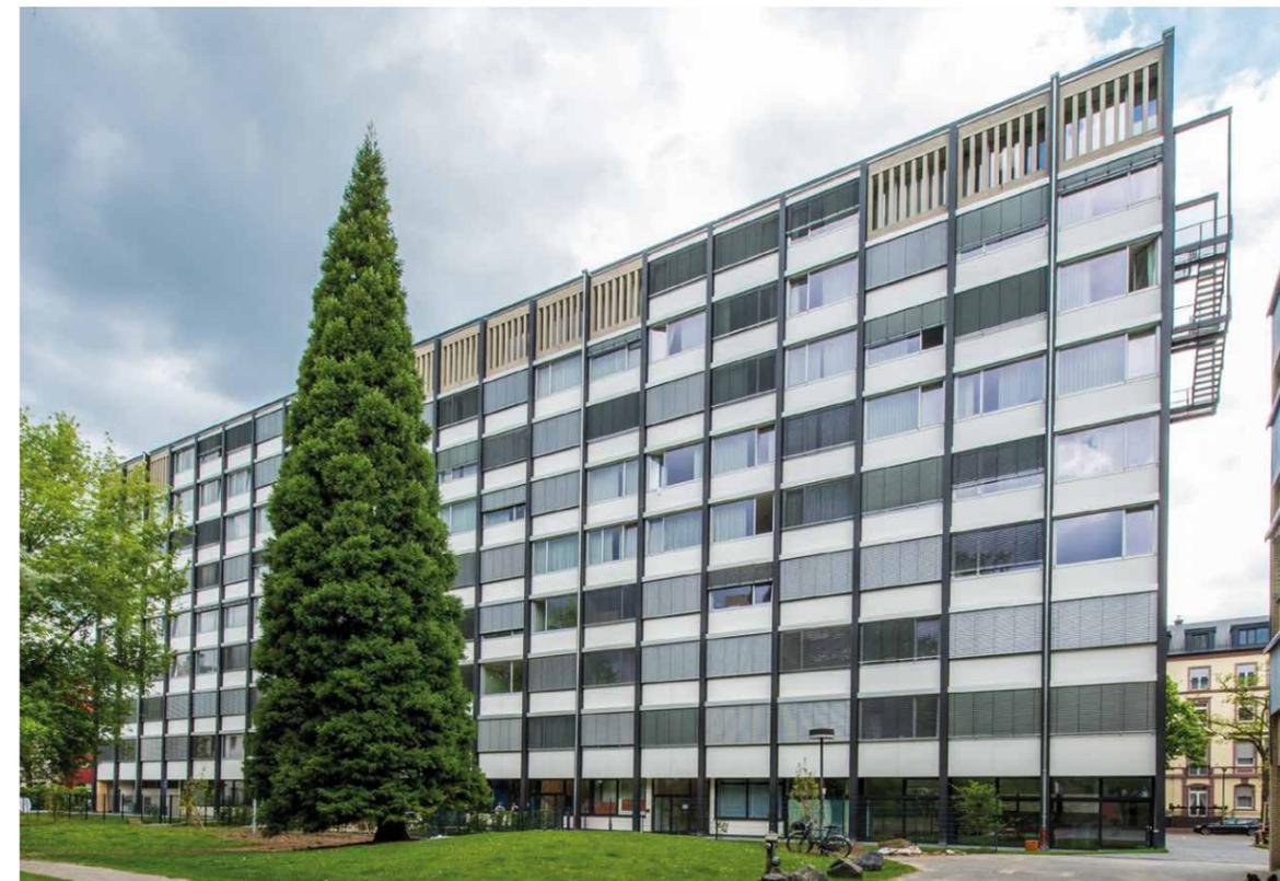
Der neugeschossige, knapp 80 Meter lange Stahlskelettbau mit einer Tiefe von nur gut zehn Metern wurde zu einem Studierendenwohnheim umgebaut. The nine-storey steel-skeleton structure, almost 80 metres long with a depth of just 10 metres, had been rebuilt as a student accommodation building.
