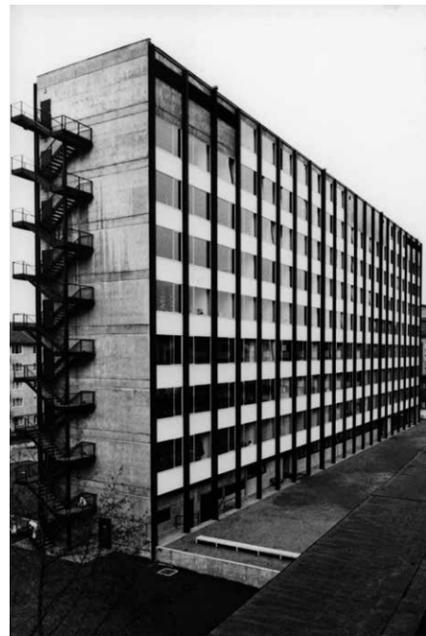
Gliederndes Element des Scheibenhochhauses ist das Raster des außenliegenden Stahltragwerks. The grid pattern on the exterior steel structure acts as an ordering element for the high-rise slab block.
