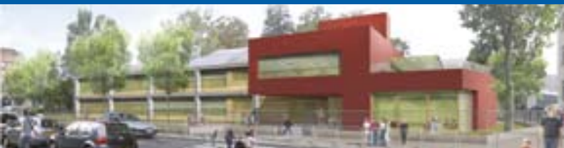
↓ Bâtiment vestiaire-foyer au stade Illwiesen, Antonelli & Herry architectes
