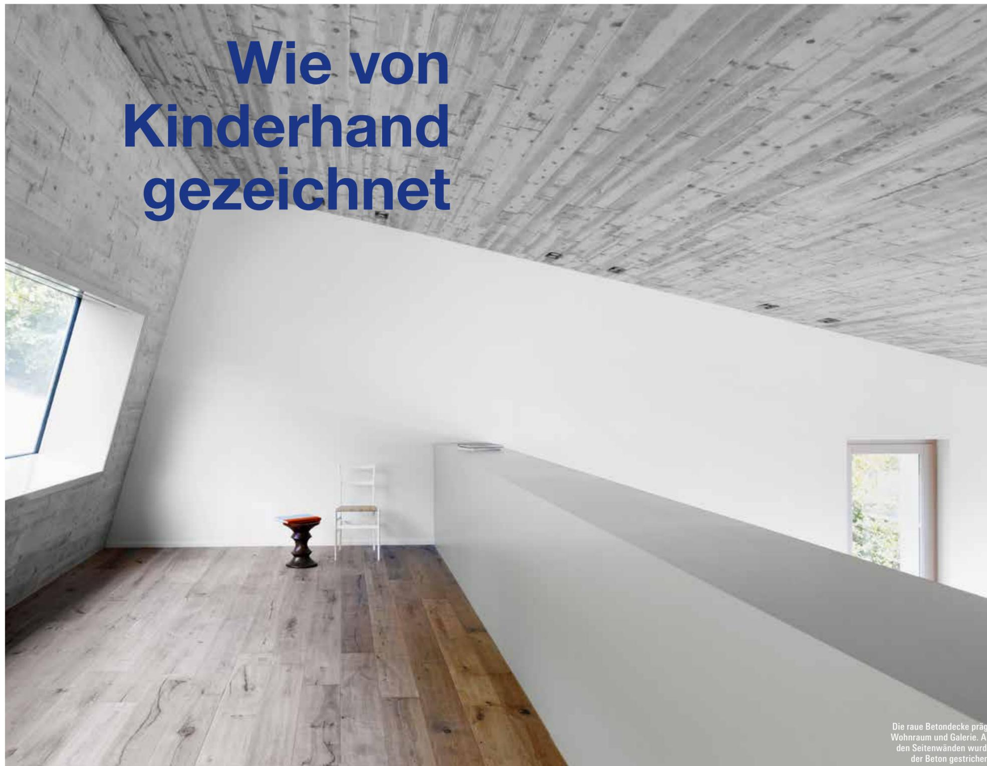
Die raue Betondecke prägt Wohnraum und Galerie. An den Seitenwänden wurde der Beton gestrichen.
