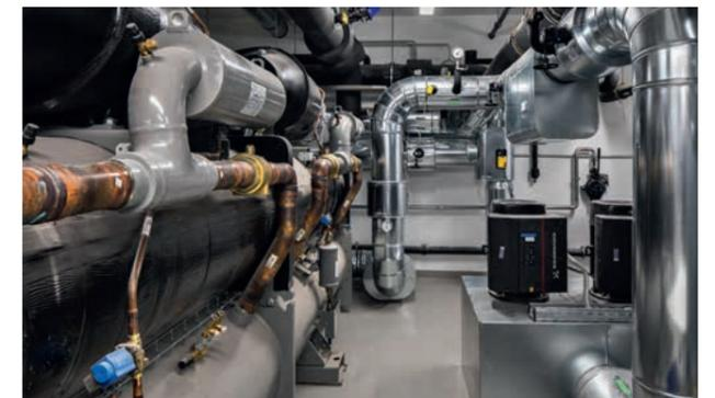
Kältezentrale-Kältemaschine ca. 1,2 MW
